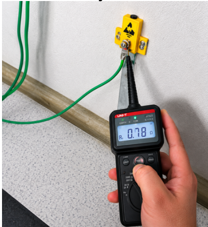
Medição do Aterramento
